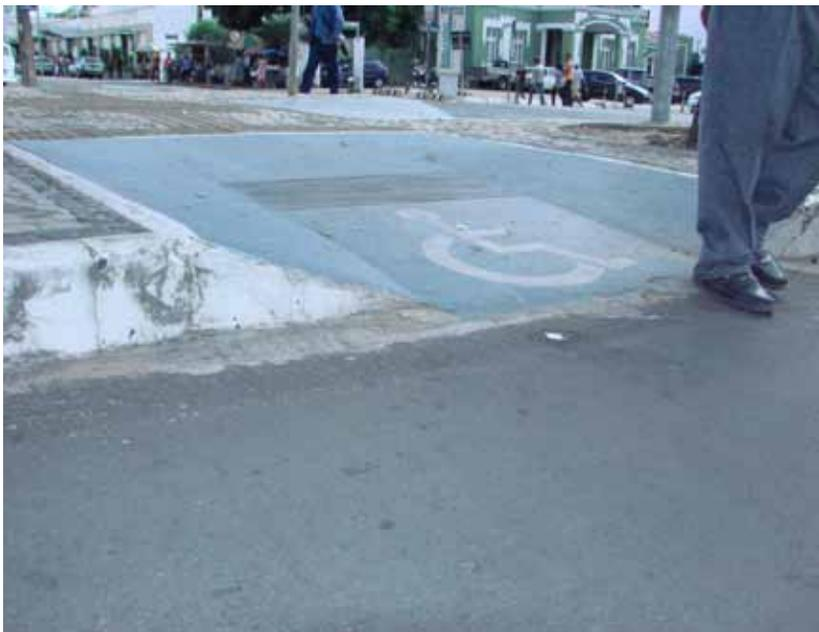
*O piso deve ser antiderrapante, regular e contínuo, sem degrau, e ter inclinação em direção ao meio fio não-superior a 2%.*
